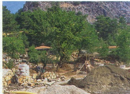
Das Katzenhaus wird abgerissen. Hier entsteht ein Tennisplatz
